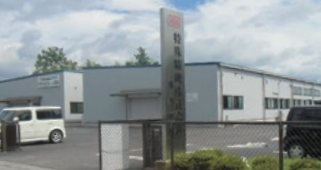
基板実装を行う那須工場
